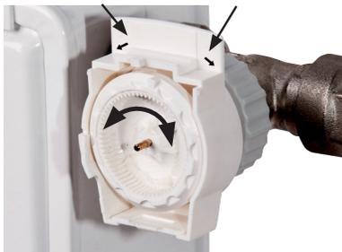
Nehmen Sie den Körper vom Umwandlerteil weg und stellen Sie das Ventil manuell durch Drehen des Zahnrades laut Bild ein.
