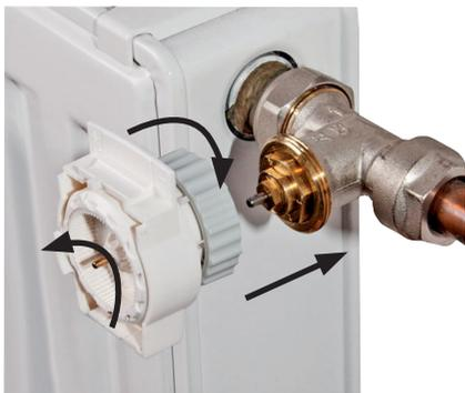
4.4 Nehmen Sie den Körper des Kopfes mit der Anzeige nach oben und überprüfen Sie, ob der Hebel der Klinke nach oben zeigt. Dann rasten Sie den Körper vom oben auf das Ventil mit dem Umwandlerteil ein.
